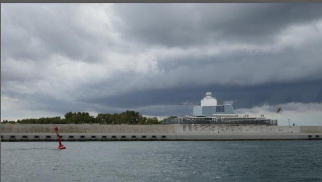
« Mossé »), [le système qui permet d'isoler la lagune de la mer en cas de montée des eaux](#) (entre 1 mètre et 3 mètres), afin de préserver Venise.
